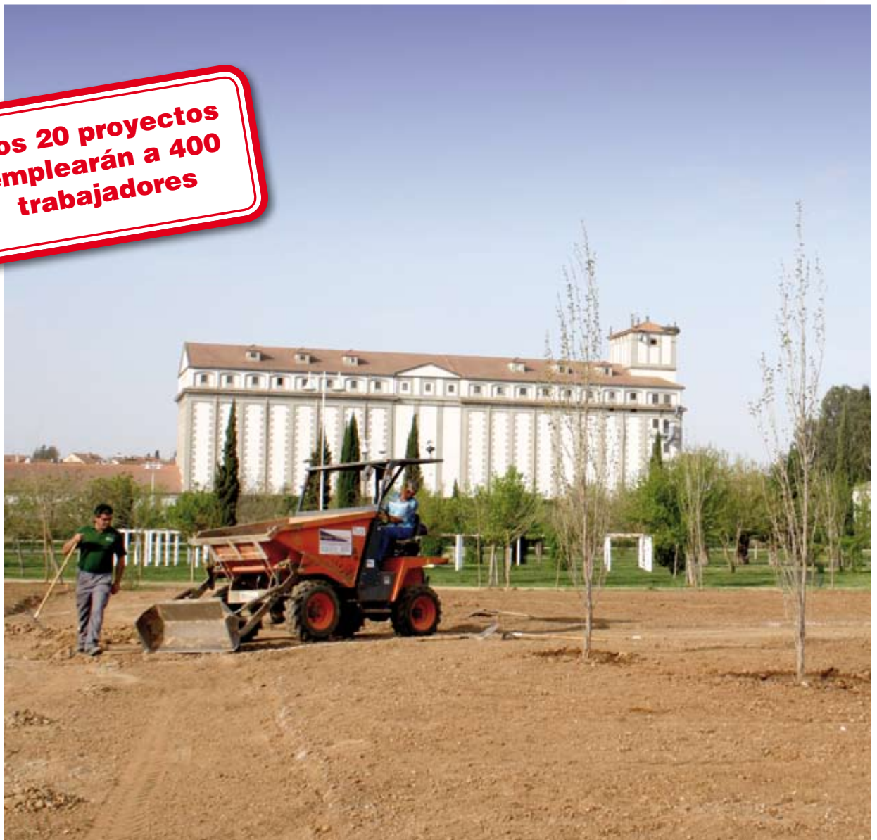
Obras de ajardinamiento en el parque Jardines del Hipódromo, del Fondo Estatal de Inversión Local
